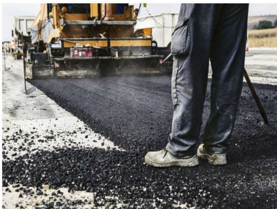
Рисунок 1. Этап в традиционном методе восстановления дорожного покрытия.
